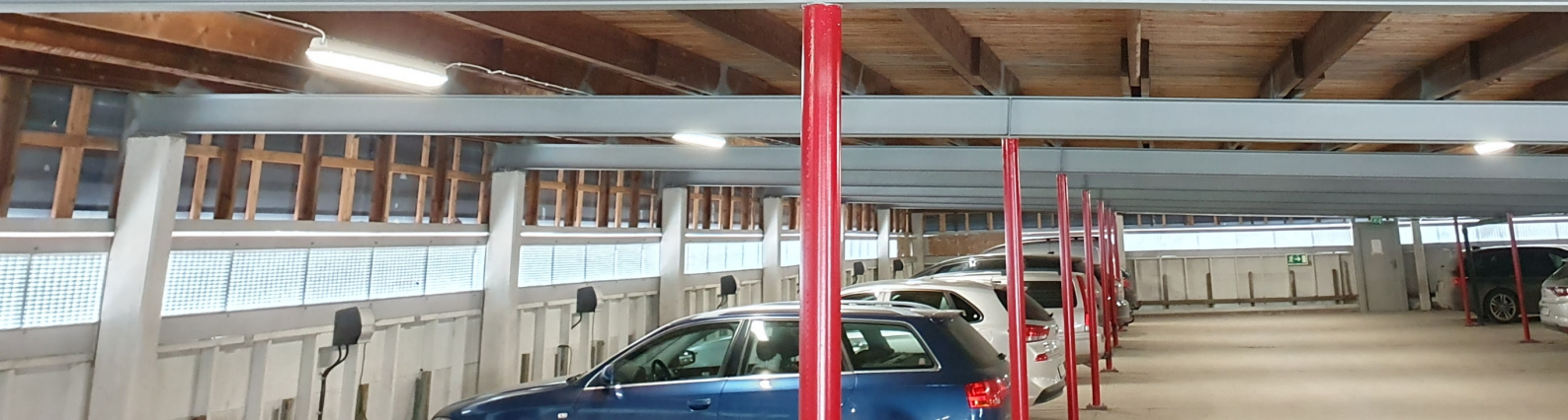
Stål/träkonstruktion – betongbalkar i kanterna
