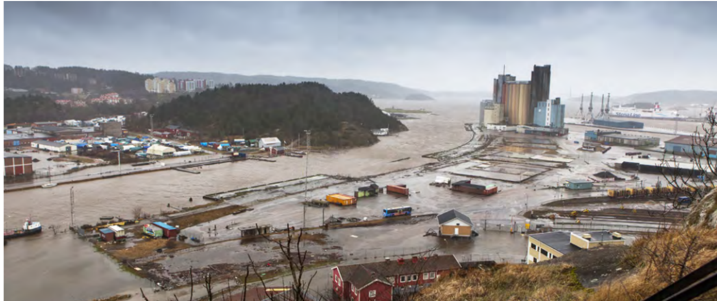
Exempel på kombinationshändelse. Bäveån möter havet under en högvattenhändelse samtidigt som det regnar. Bildkälla Uddevalla kommun.
