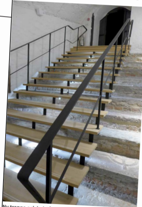
Ny trappa och ledstång ovanpå den gamla trappan i Kalmar slott.
