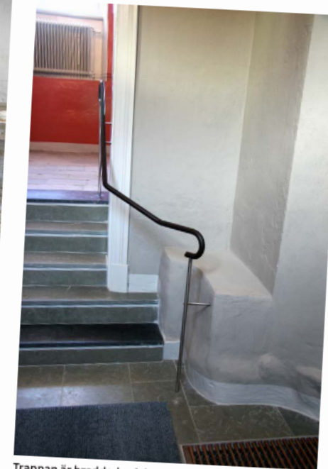
Trappan är breddad och har en ny ledstång, Linneanum i Uppsala.
