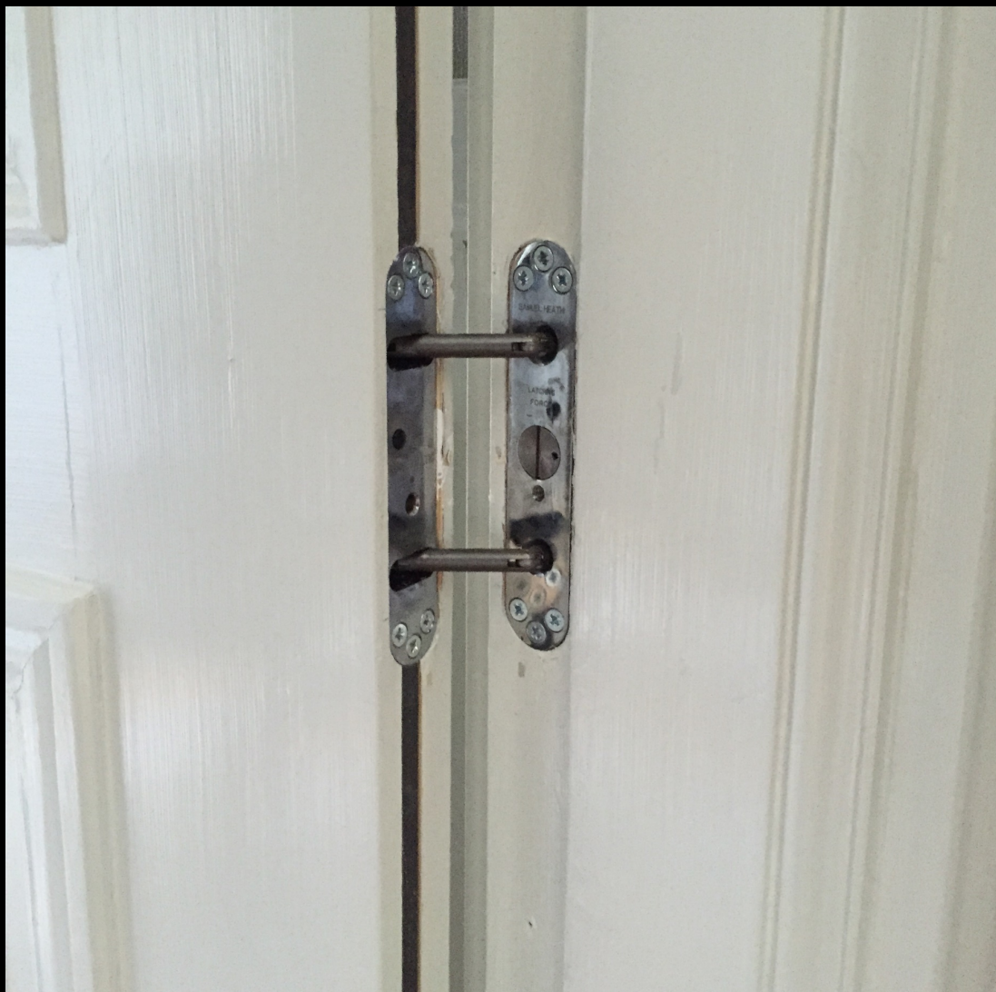
Exempel på dold dörrstängare – så kallad free-swing
