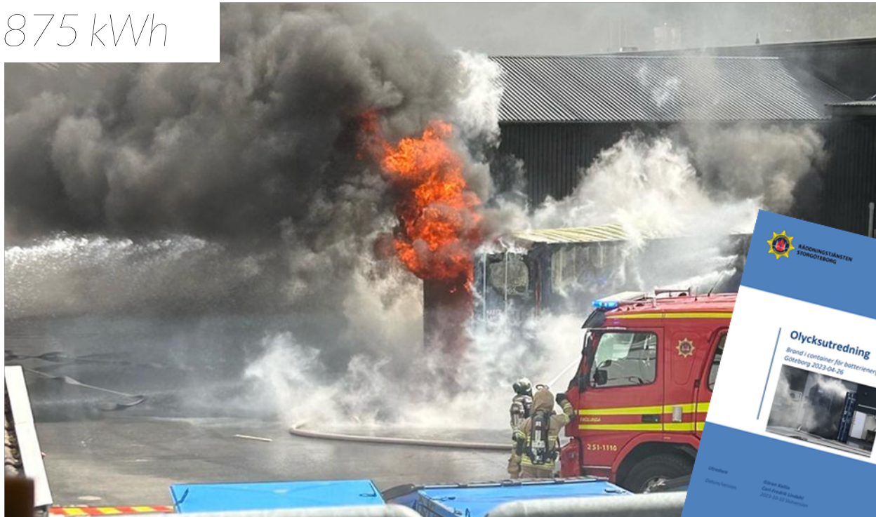
Foto: Göteborgs Posten, Läsarbild (Branden i battericontainer Sisjön)
