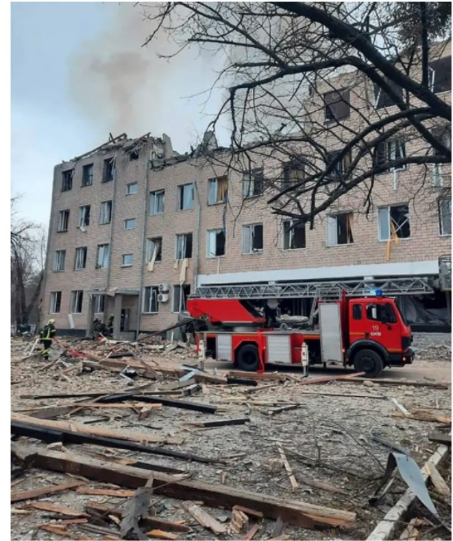
STORE SKADER: Et bilde tatt av ukrainske myndigheter viser skadene etter en eksplosjon ved en militær bygning i hovedstaden Kyiv. Foto: Interior Ministry press service HANDOUT / EPA
