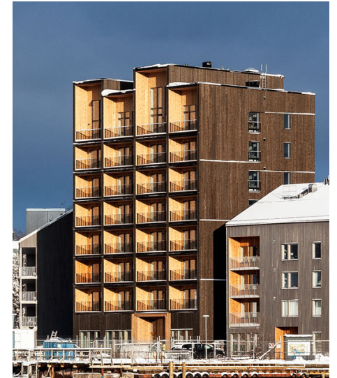
KAJSTADEN VÄSTERÅS 9 STOREYS
